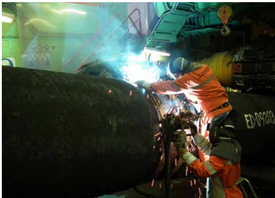
Сварка труб Северного потока на судне-трубоукладчике Castoro Sei.
