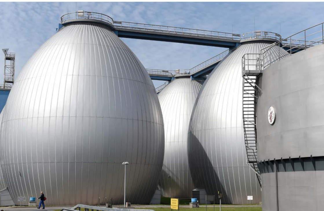
Очистные сооружения для производства биогаза в Гамбурге, Германия.
